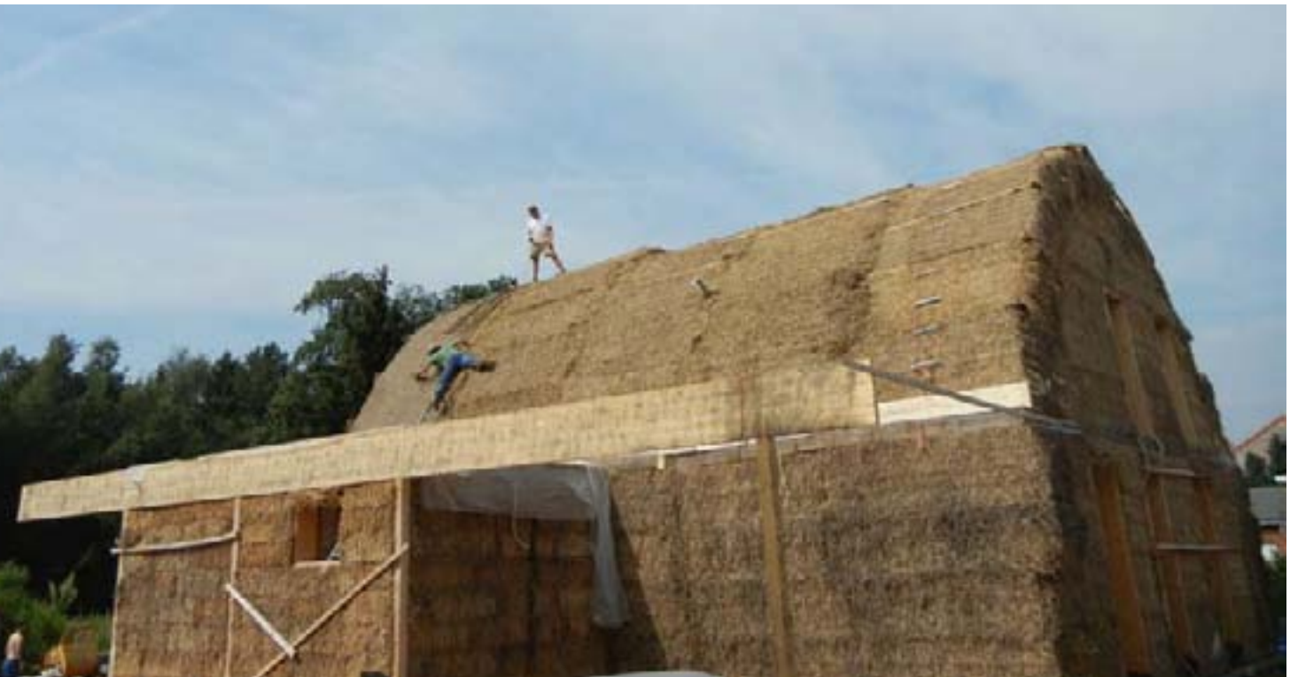
Kies voor natuurlijke materialen uit eigen streek: bv. stobalen en leem. Arch Henk Van Aelst, Foto Bruno Cassiers
