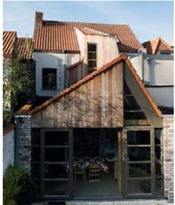
Rijwoning in de stad, verbouwd met bio-ecologische materialen en een laag energieverbruik.
